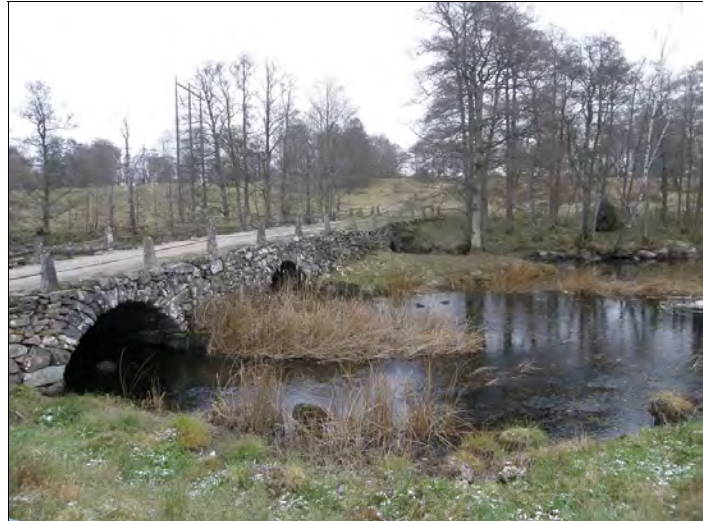
Fig. 9. Gamla landsvägsbron över Mörrumsån med spår av vattenkraftutnyttjande. Foto från sydväst.
