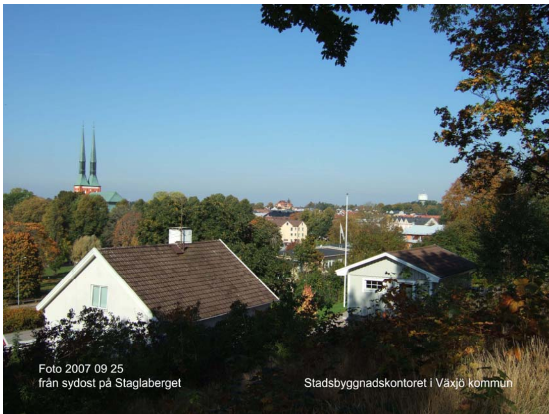
Från sydost på Staglaberget med befintlig byggnad
