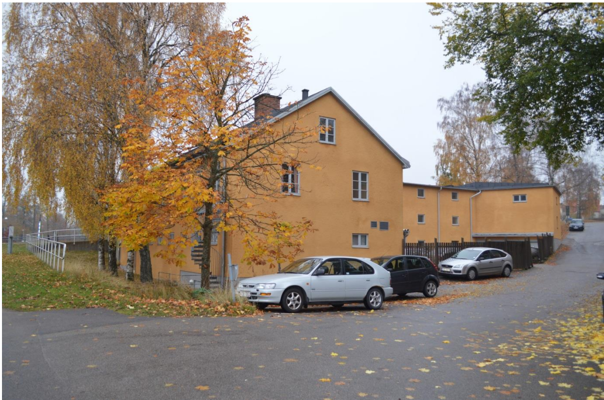
Bild 15. Sigfridshäll. Även baksidans karaktär har bevarats med ursprungliga fönster, taktäckning och putsutformning. Backen till höger utgjorde ursprungligen den gamla häradsvägen. Foto: Samuel Palmblad
