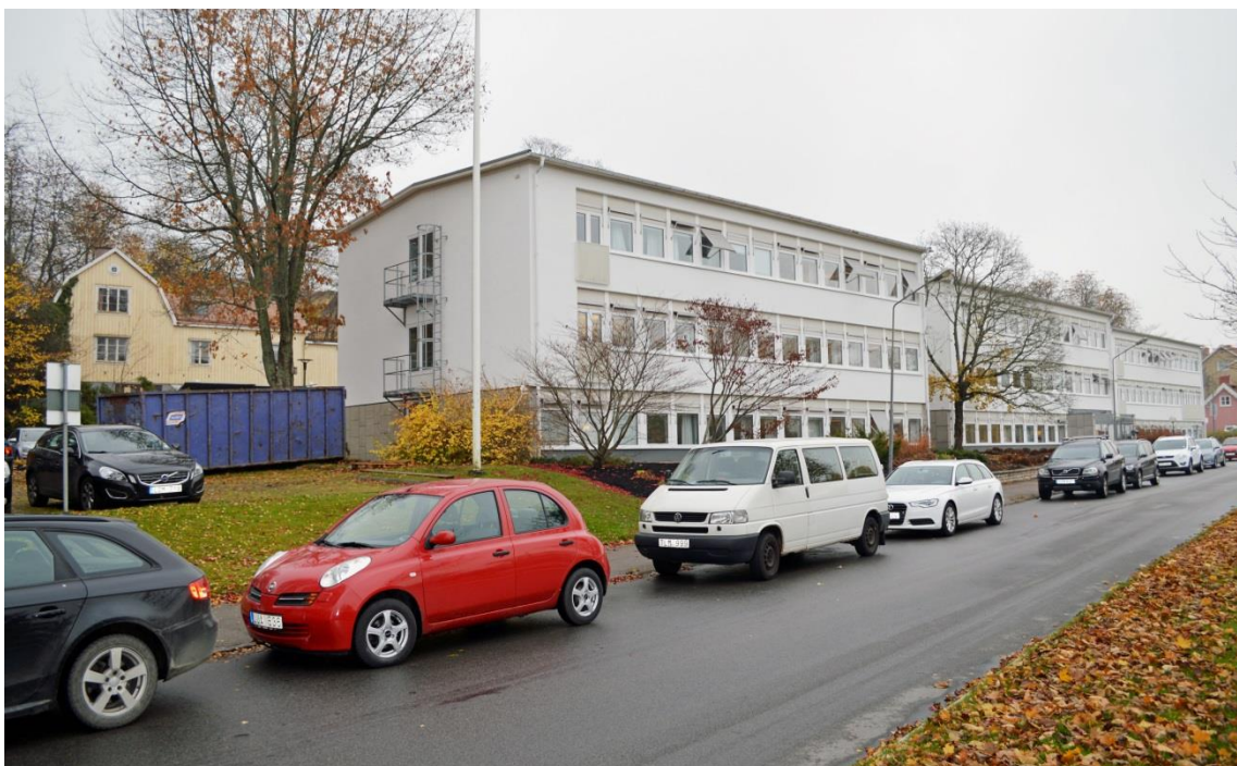
Bild 16. Södra skogsägarnas kontorskomplex från 1959 som sedermera övertogs av Landstinget. Huset till vänster är Byggmästaren 18 som utmärker sig genom sin placering utmed bergssluttningen. Baksidan utbyggdes år 1970 då garagen bl.a. tillkom. Foto: Samuel Palmblad
