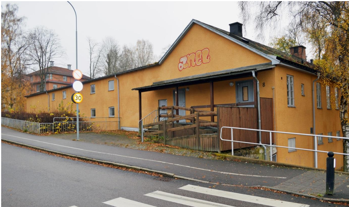
Bild 14. Sigfridshäll. Entrépartiet förändrades på 1980-talet. I övrigt är exteriören närmast orörd. Foto: Samuel Palmblad
