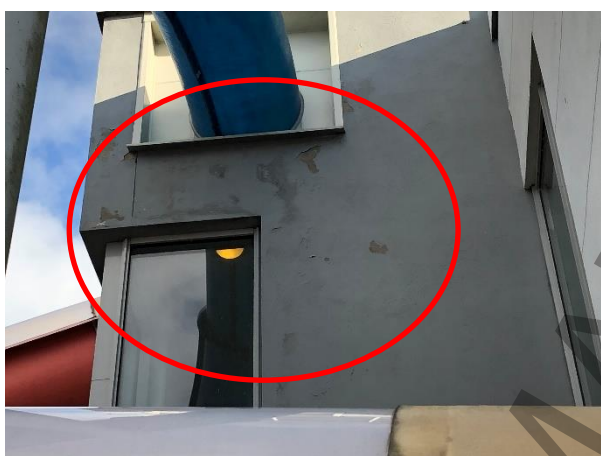
Foto 61, skador i fasader vid trapphus/vattenrutschkanan.
