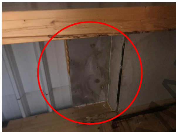
Foto 38, skador ovan innertak.
