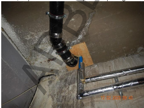
Foto 5, bjälklag under kök
