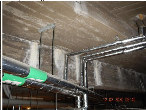
Foto 6, bjälklag under kök
