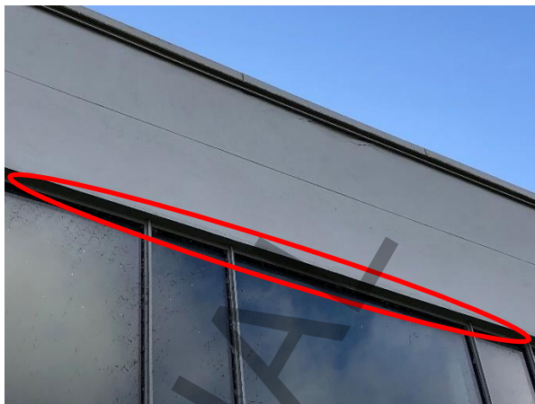
Foto 60, sprickor i putsade smygar del 3.
