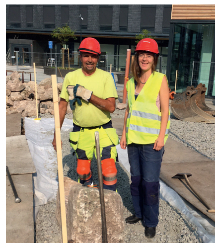
Peter Friis Madsen hjälper Linnea Jörpeland bygga muren vid konstverket "På väg".
