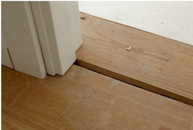
figur 45. Ingen nivåskillnad, glipan täcks med list.
