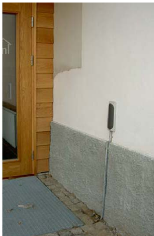
figur 17. Dörröppnaren i figur 16 placering i förhållande till dörren.
