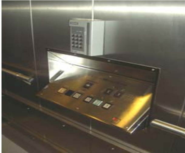
figur 23. Hisspanelen med siffror i relief och punktskrift, hissen är utrustad med tal.
