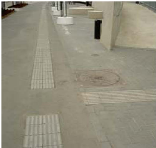
figur 4. Taktilt ledstråk med en avvikande del i ledstråket som visar att här finns en annan riktning på vägen.
