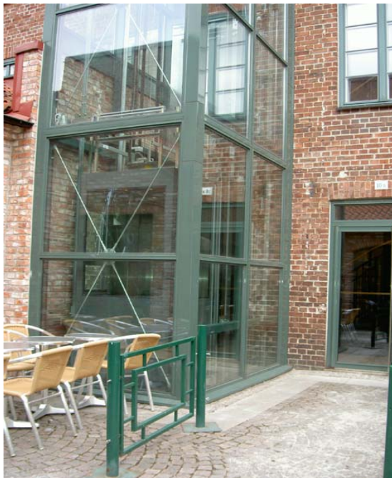
figur 22. Estetiskt tilltalande hissinstallationer som smälter väl in i miljön.
