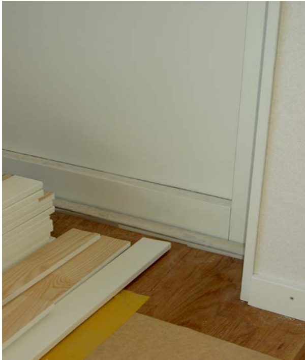
figur 43. Utgång till balkong, nivåskillnad 5mm
