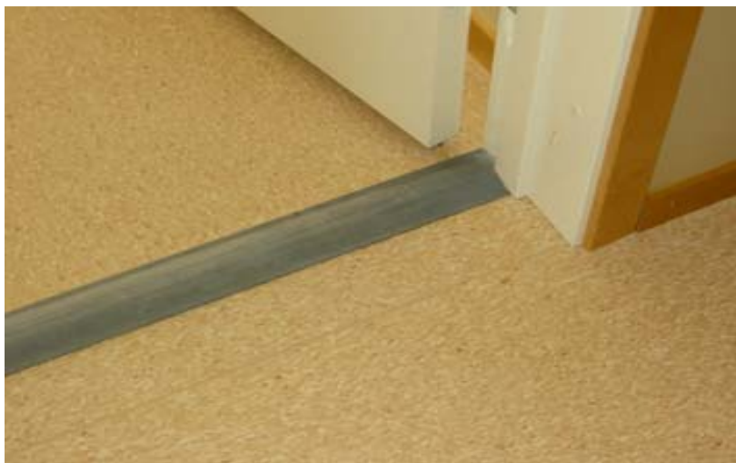
figur 46. Gummitröskel, används ofta i offentlig miljö/ vårdinstanser mm. Reducerar ljud och fördröjer brand/rökgasspridning.
