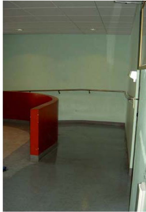
figur38. Avslutningen på rampen i fig.32.
