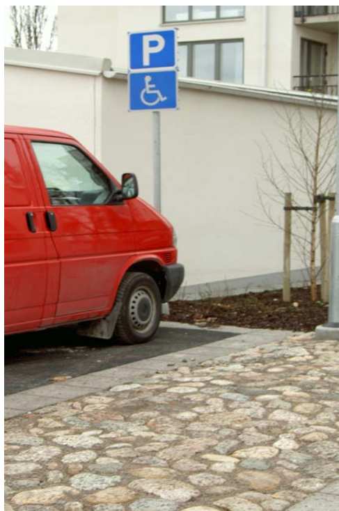
figur 47. Parkering i bostadsområde avsedd för funktionshindrade. Jämn markbeläggning på vänstra sidan om bilen.
