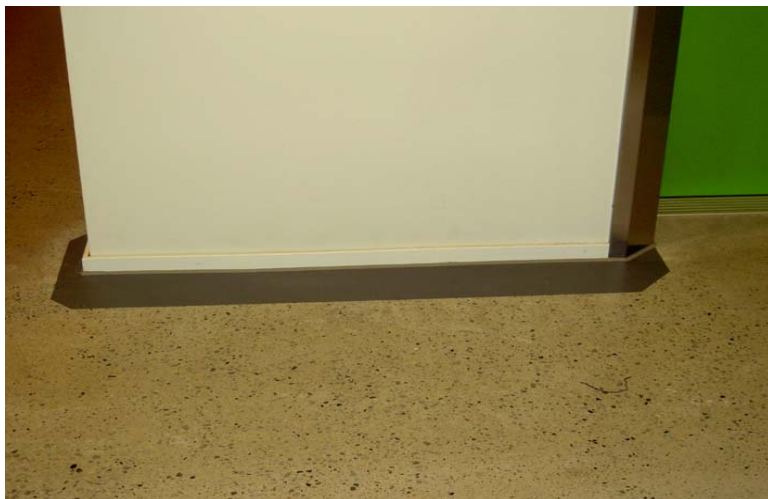
figur 8. Kontrastmarkering mellan golv och vägg.
