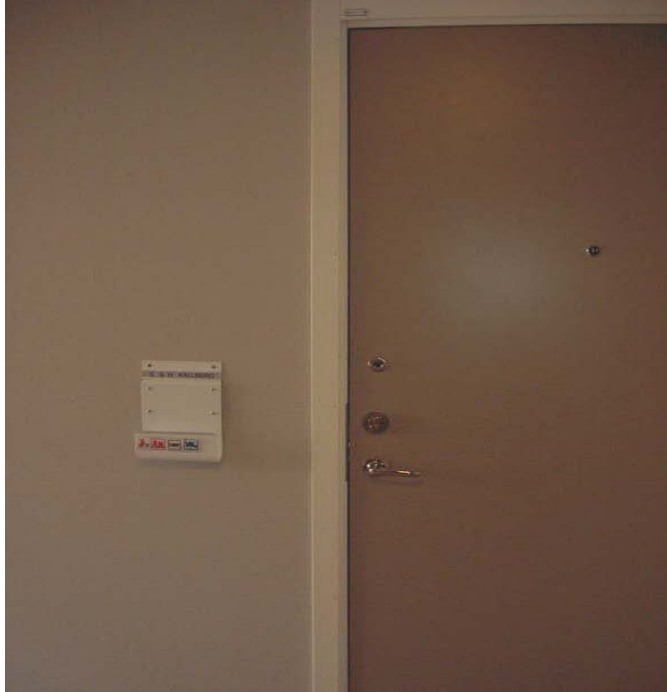
figur 6. Kontrastmarkering mellan vägg och dörr.
